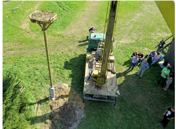
Рисунок 27. Процесс установки платформы завершен.
