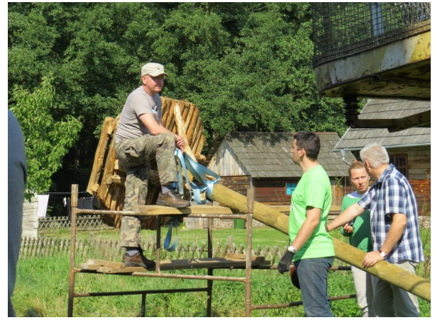
Рисунок 17. Для подъема используются прочные веревки, которым обвязывается конструкция.
