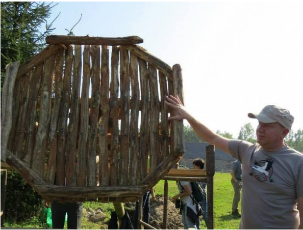
Рисунок 14. В основании платформы необходимо оставлять щели для стока воды, вентиляции, т.е. для предотвращения гниения основы.
